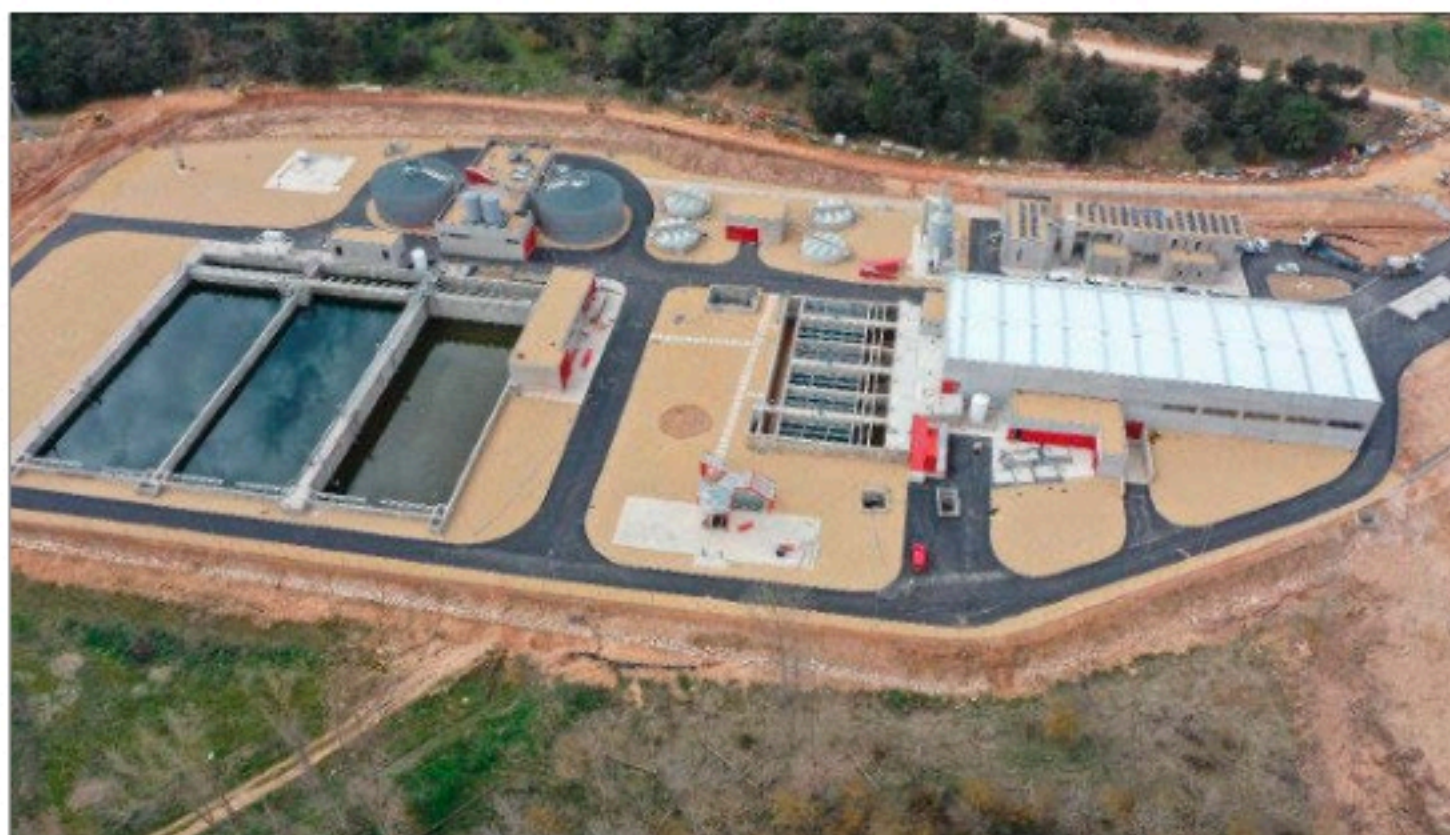
Panorámica aérea de las instalaciones de la depuradora de Soria en Sinova. HDS
